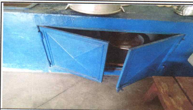
foto 8: Sstitución de puertas de mueble de concreto
