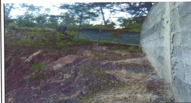
Foto 5: Sustrucción de muro.
