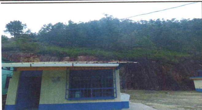
Foto 1: Sustrucción de lámina troquelada dañada.
