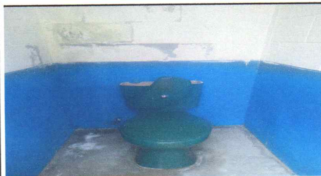
Foto 3: Sustrucción de tazas sanitarias.
