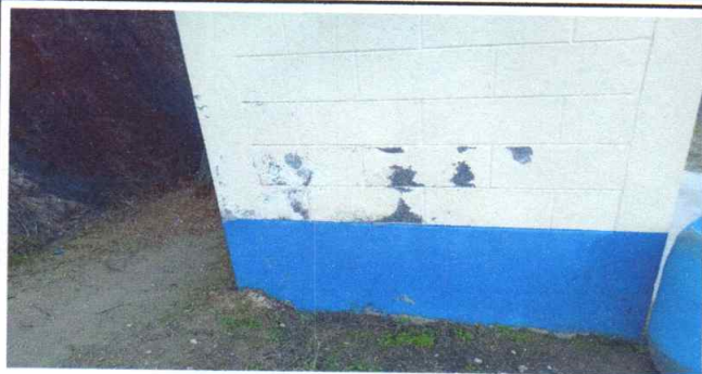
Foto 7: Pintura de pared de cocina y sanitarios en mal estado
